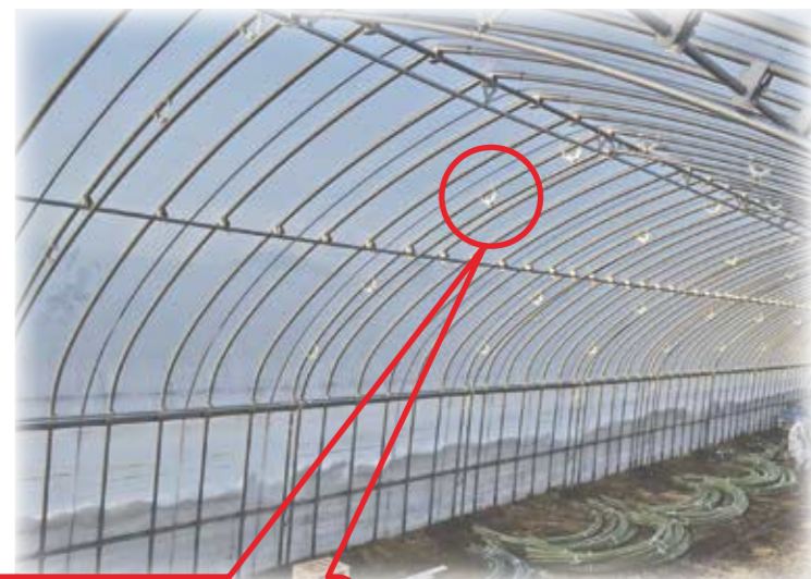
平成31年1月 北斗市内組合員宅園場での施工状況
