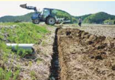
写真1 額縁明きょの施工
